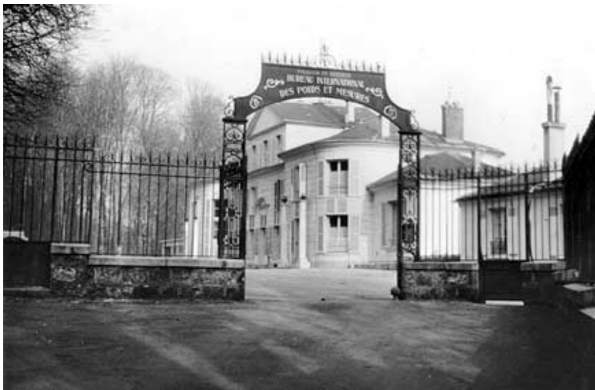
Pavillon Breteuil au parc de Saint-Cloud
